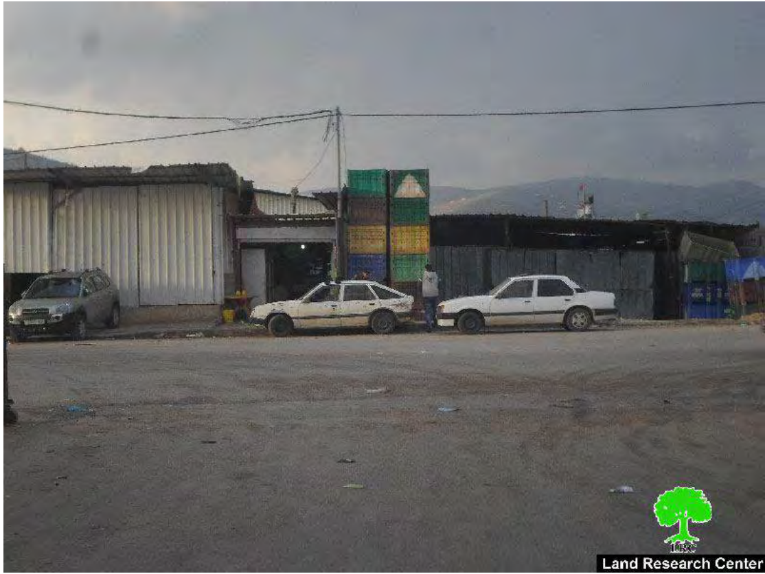
بيتا - محافظة نابلس: سوق الخضار المركزي هددته الاحتلال بالهدم - صورة قبل الهدم - شباط 2016م
